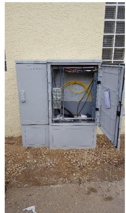
Vorteil dieser Lösung ist, dass die Kupferdoppeladern zwischen unserem Netzwerk und den Kundenhaushalten dadurch sehr verkürzt wird. Über Kupferkabel lassen sich Daten zwar schnell übertragen, aber nur im Nahbereich. Sobald die Kupferkabelstrecke zu lang wird, sinkt die Datenrate. Bisher wurden diese Kupferkabel bis nach Donaustauf weitergeführt, was diese für schnelle Datenübertragungen nahezu unbrauchbar macht. Dadurch, dass wir alle 3 KVZs erschlossen haben, sind die
